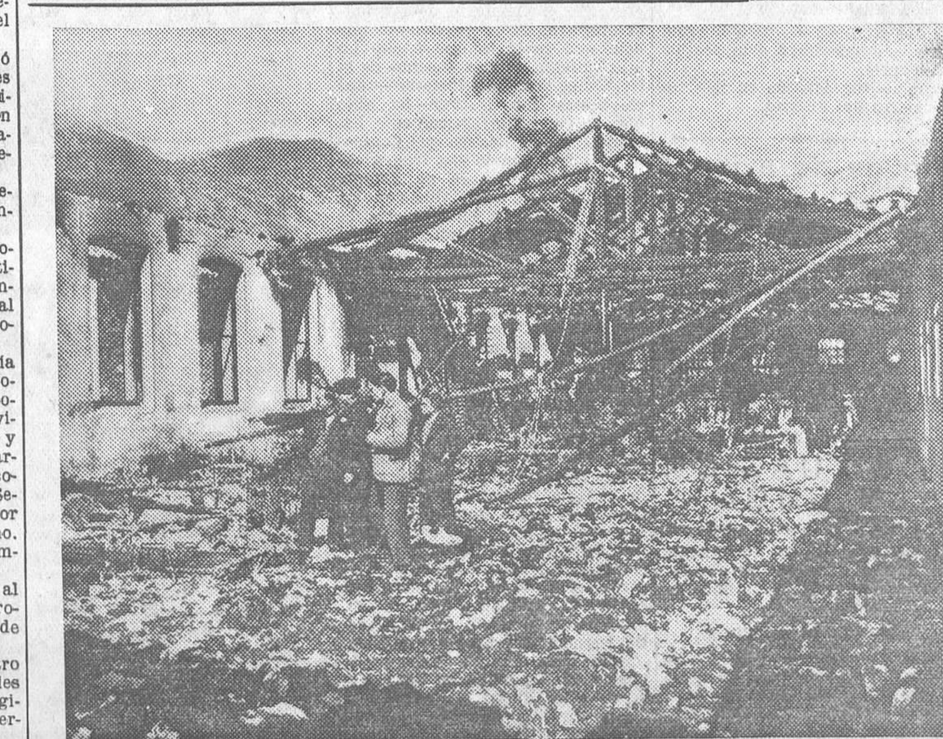
BARCELONA.—Fábrica de tejidos propiedad del Sr. Pujol, donde la explosión de una bomba incendiaria produjo un siniestro duro que dejó reducido a escombros el edificio, con una pérdida de más de 30.000 duros, y quedando sin trabajo doscientos obreros
