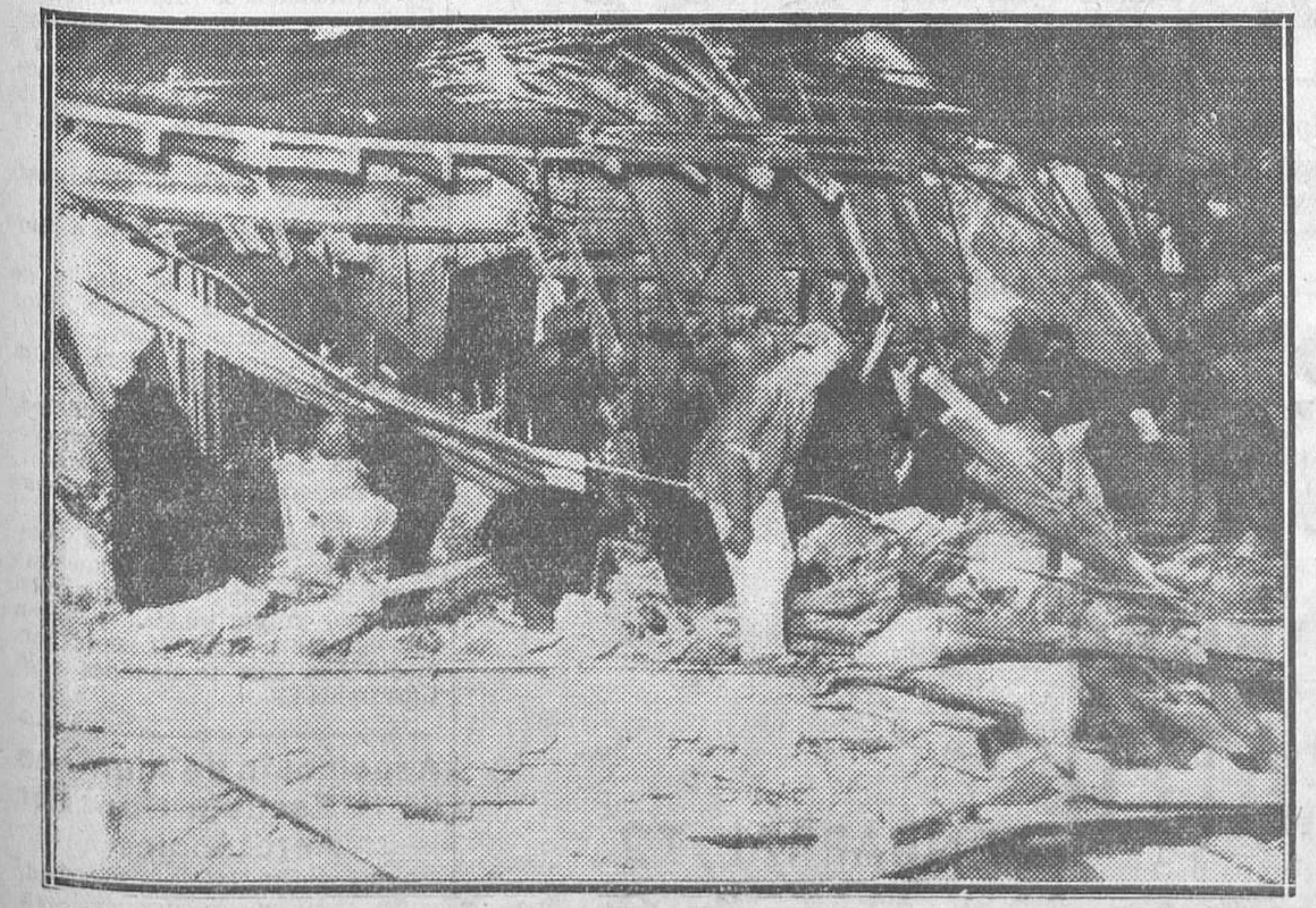
EL TEMBLOR DE TIERRA EN LOS ANGELES.—Primeras fotografías que muestran los terribles daños causados por la catástrofe (Fot. Orttis-Keystone.)
