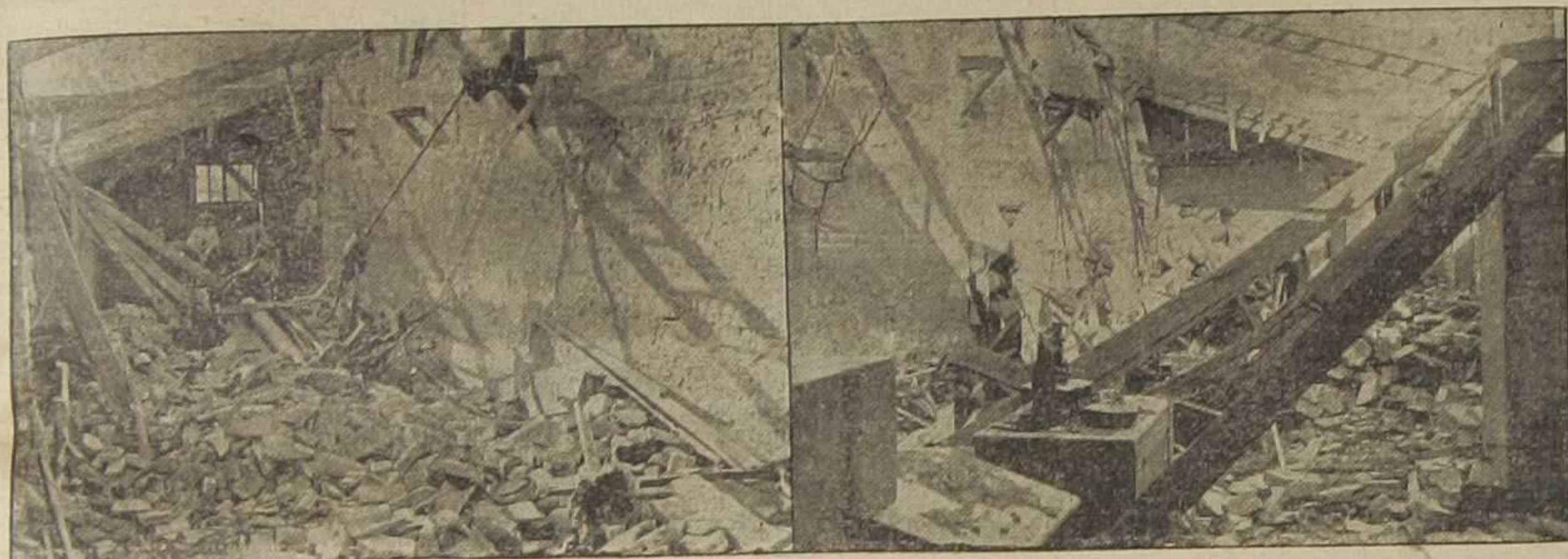
Estado en que ha quedado el departamento de la fábrica de sacos de D. Valentin Bou (Camino de Barcelona), entre cuyos escombros quedaron sepultadas numerosas obreras. —(Fotos. Vidal.)
