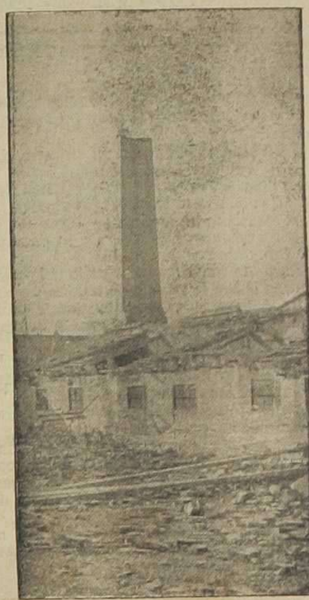
Estado en que ha quedado la chimenea derrumbada y que tantos estragos ha causado
