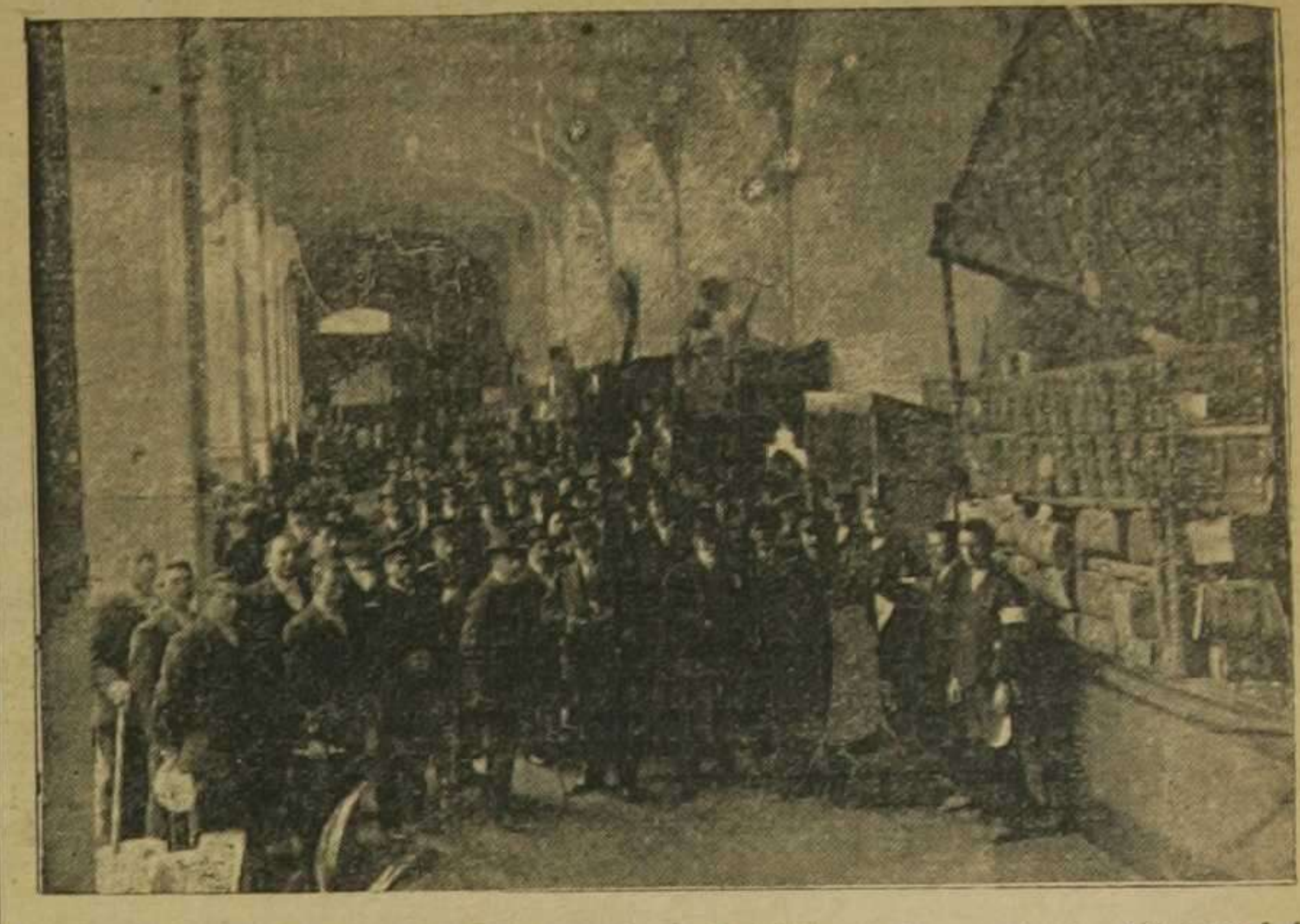
Inauguración de la Exposición de trabajos industriales de los reclusos del penal de San Miguel de los Reyes. (Foto. Cabelo.)
