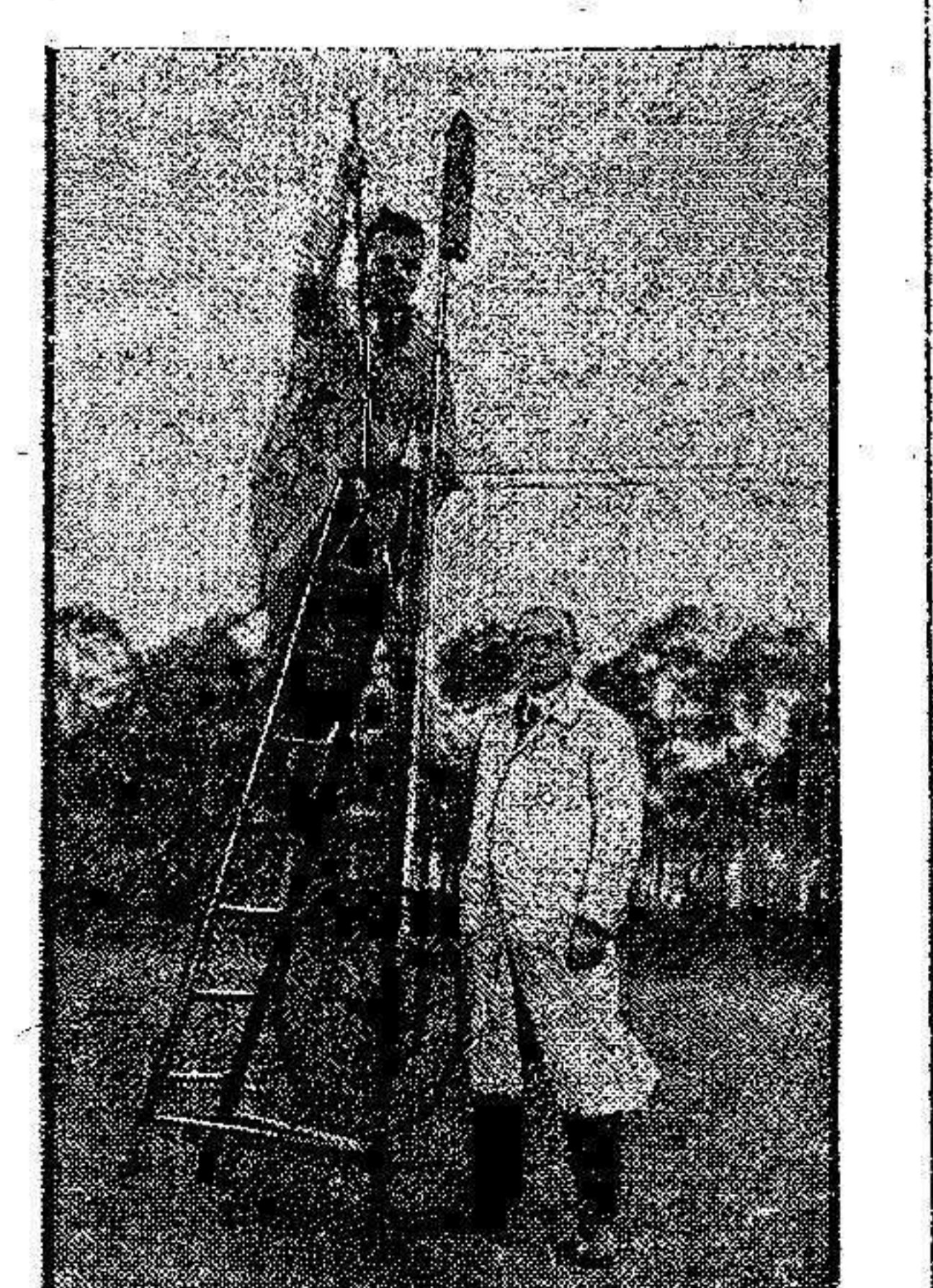
Actualmente se procede en Berlín a la construcción de un nuevo aerodromo, provisto de todos los elementos modernos, destinado a la aviación comercial. La foto muestra a los ingenieros instalando uno de los magníficos aparatos que habrán de servir para la orientación nocturna.
