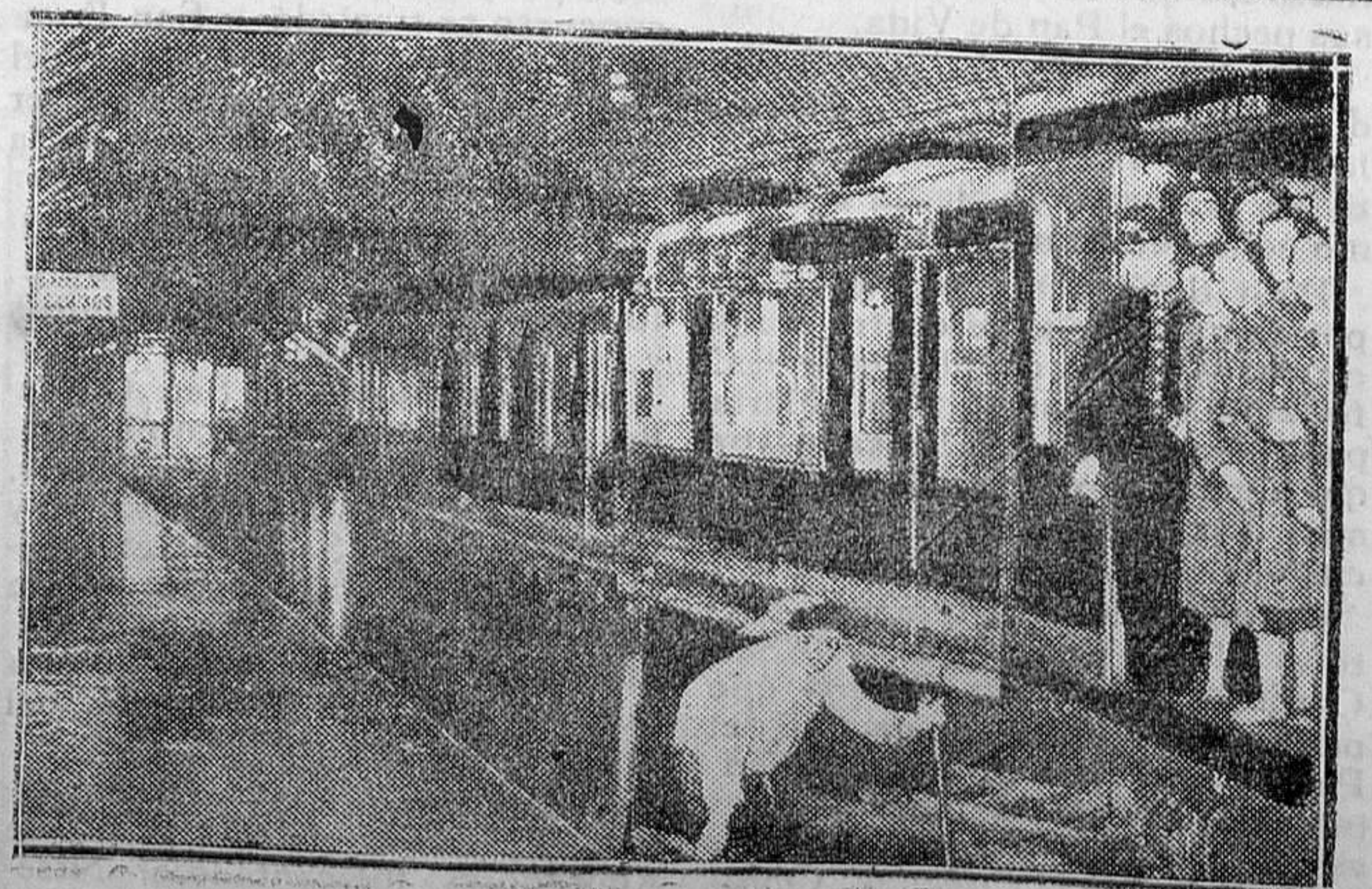
MADRID.—Una violenta tromba de agua invadió la estación del Metro del Noviciado. En la foto se ve el estado en que quedó.
