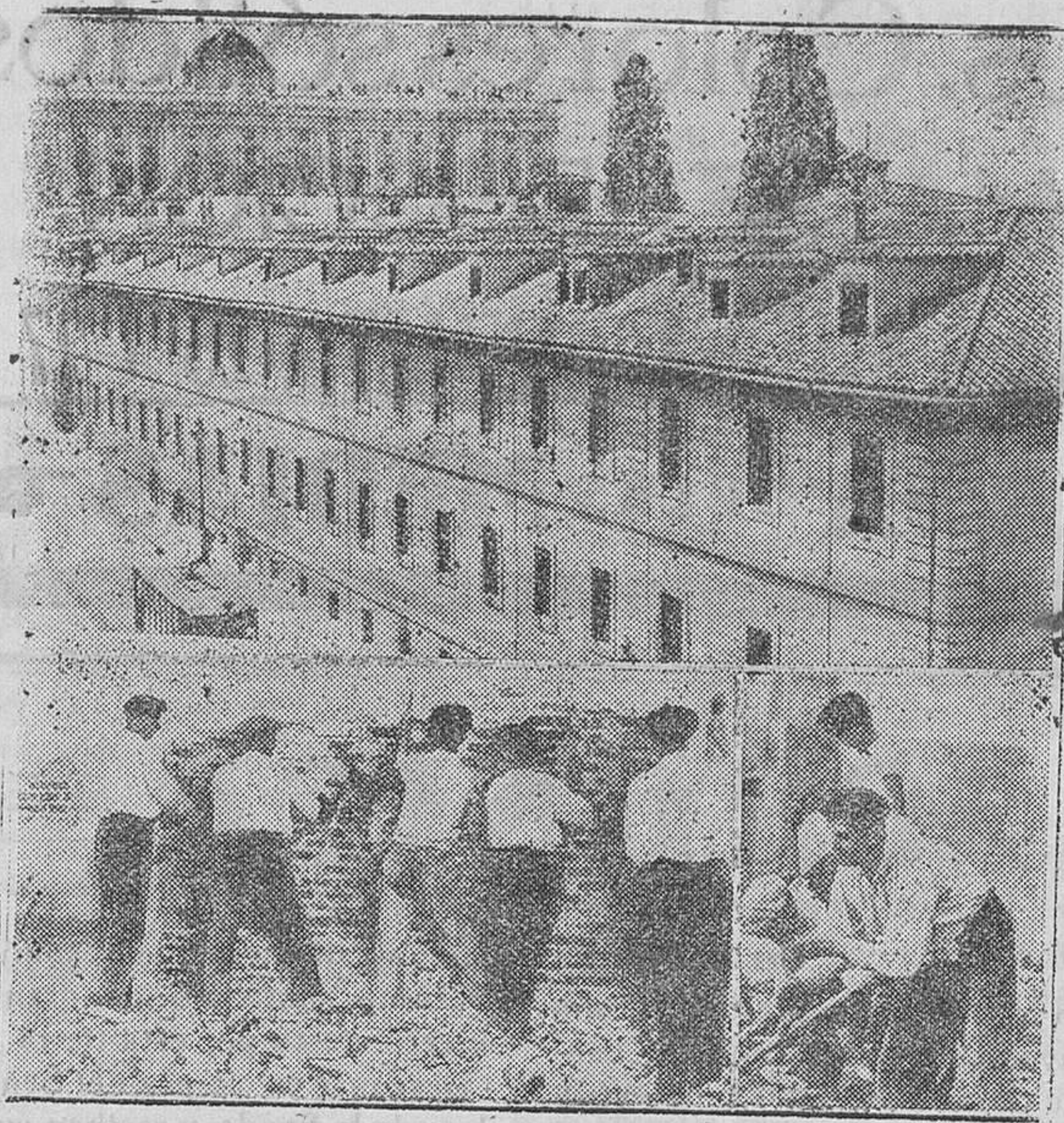
MADRID.—Comienzo del derribo de lo que fueron Caballerizas Reales, adosado al Palacio Nacional.—Una vista de las Caballerizas y los obreros empezando el derribo
