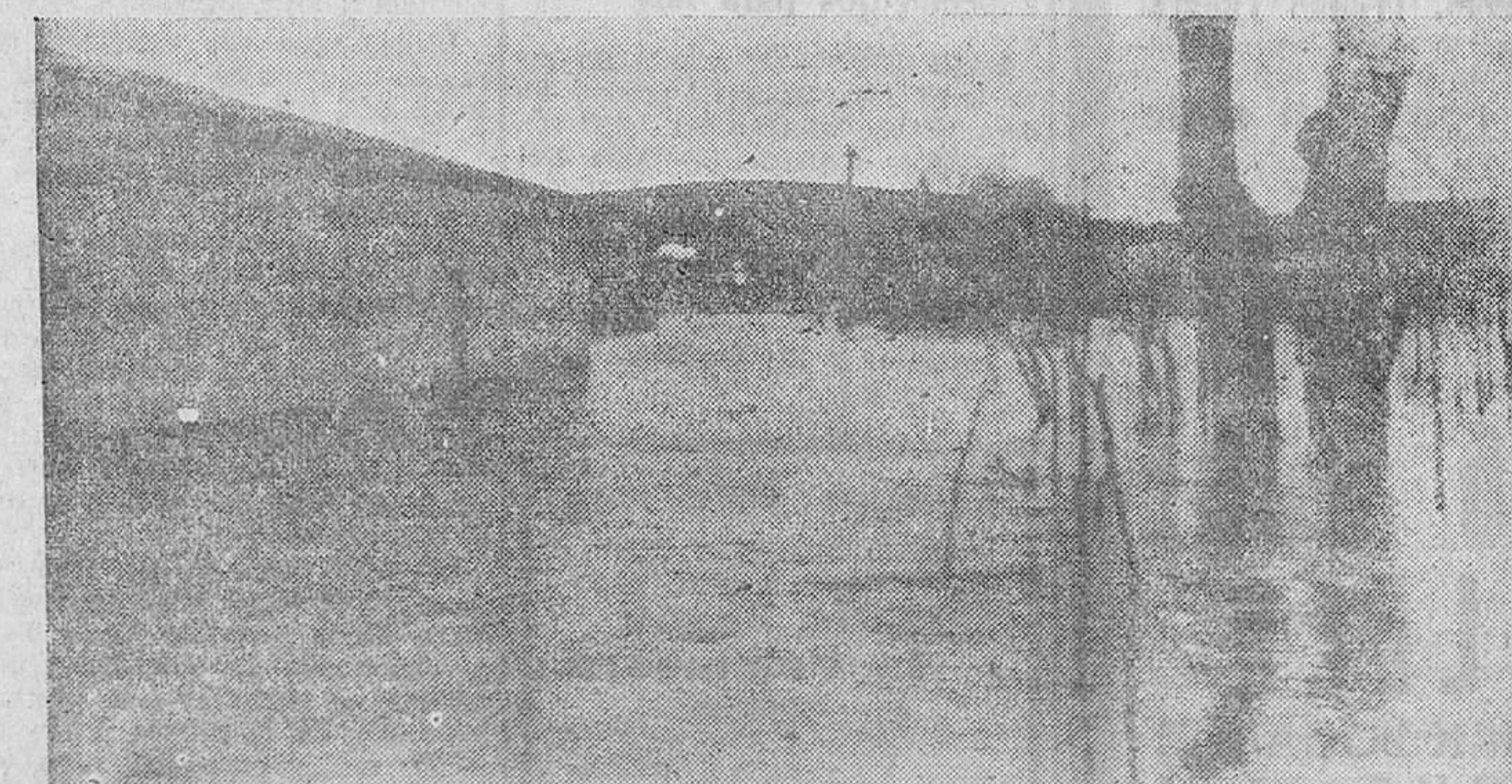
La carretera de Carrascal cortada en un gran trecho.—(Foto Juanes)
