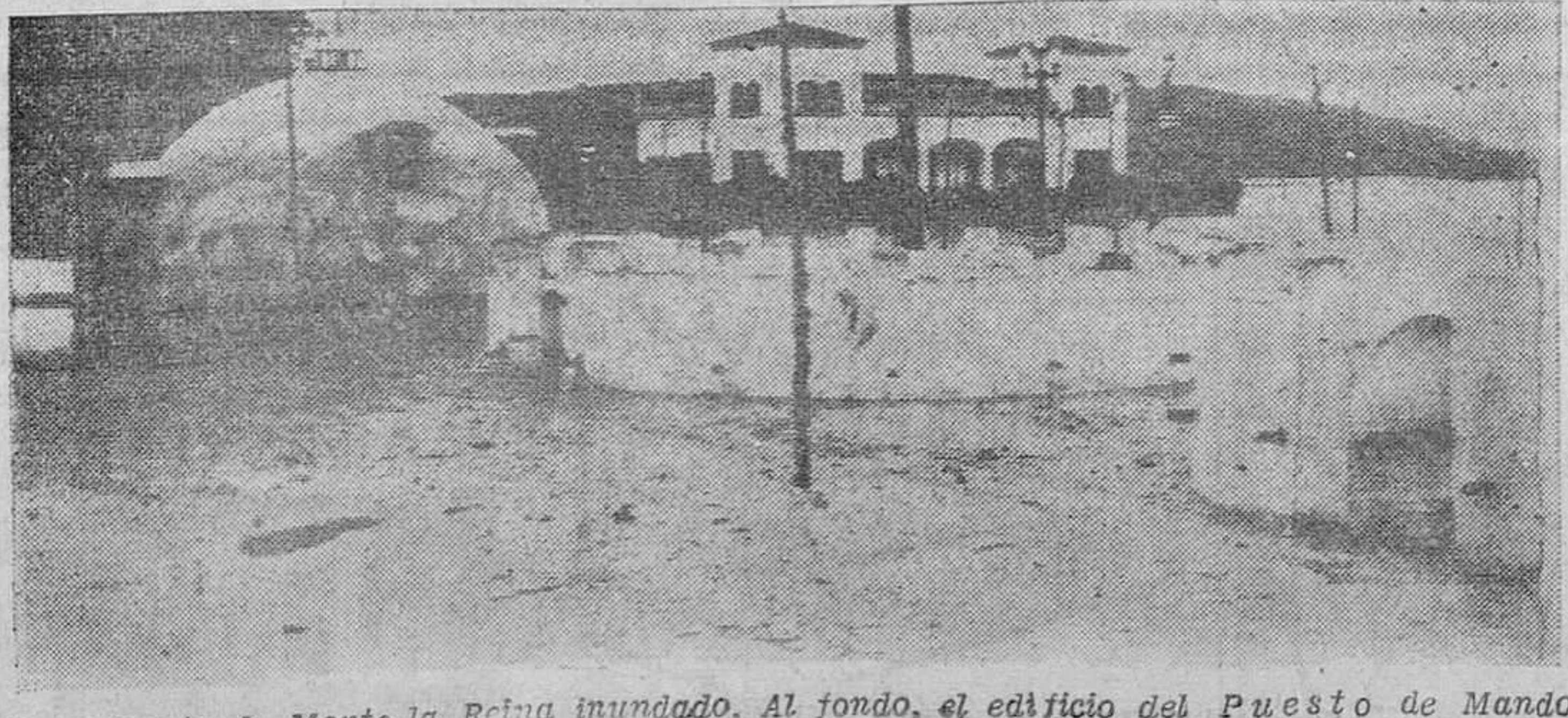
El Campamento de Monte la Reina inundado. Al fondo, el edificio del Puente de Mando.—(Foto Juanes)
