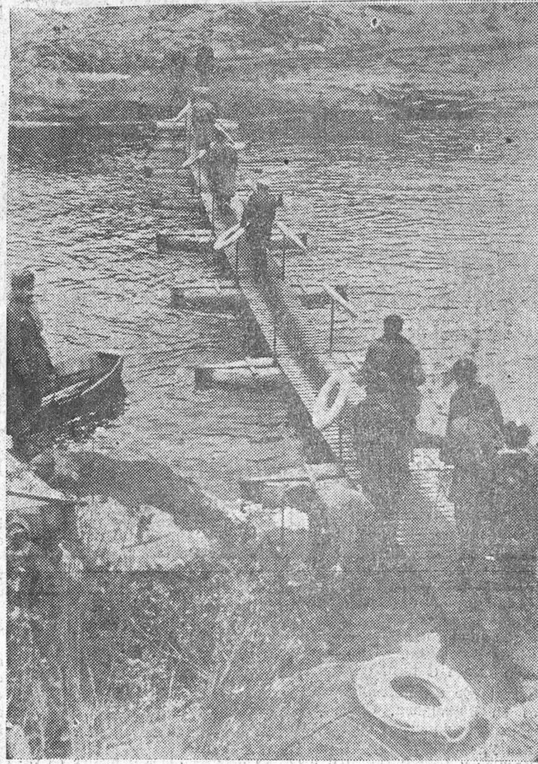
Fuerzas de Ingenieros de Salamanca, tendieron en poco más de veinte minutos dos puentes sobre flotadores para facilitar el paso sobre el Tera y comunicar la carretera con Ribadelago. Las "fotos" nos muestran a los soldados en pleno trabajo, y una vez terminado, el paso de personas sobre uno de los puentes. En una de estas "fotos", el señor Ministro de Obras Públicas utiliza el nuevo y provisional paso.
