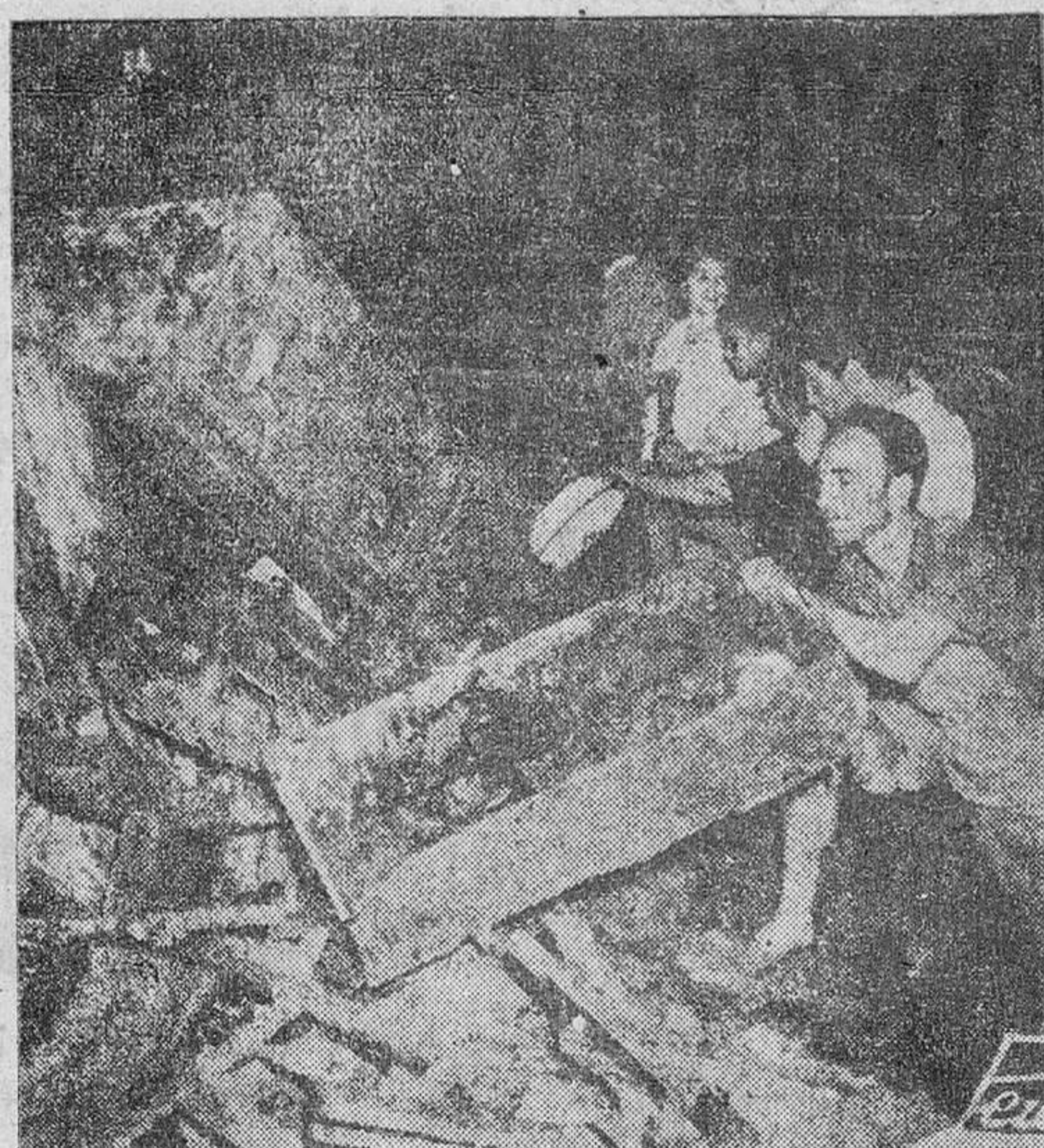
Una humilde familia buscando, entre los escombros y el barro, los destruidos enseres de su hogar.
