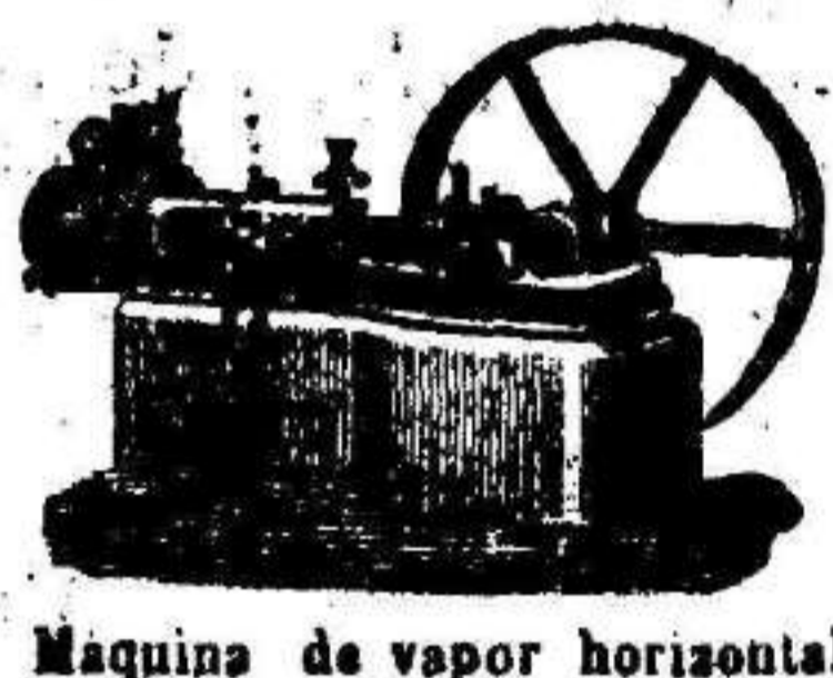
Máquina de vapor horizontal
