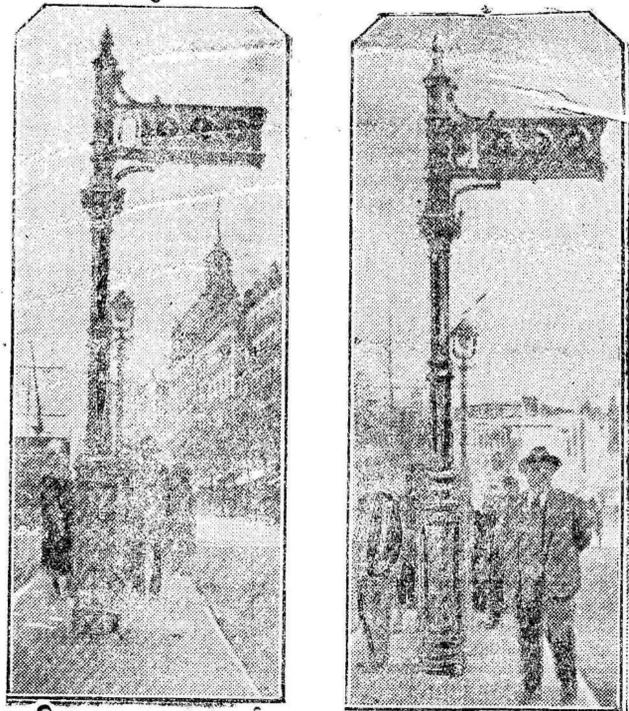
Farolas luminosas de tres discos instaladas en la calle de Alcalá para regular el tránsito, y que sustituirán en los puntos de mayor movimiento las funciones de los guardias de la porra.
