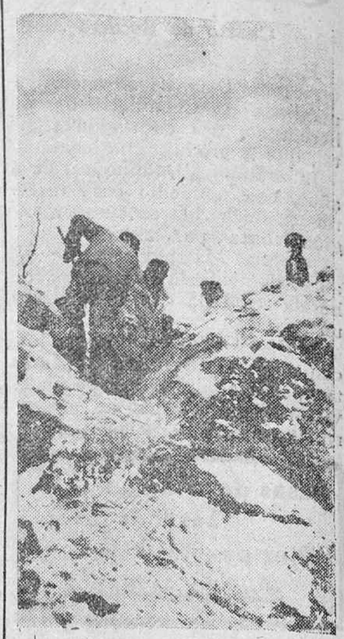
Trabajos de fortificación se llevan a cabo en uno de los aeródromos del Norte.
