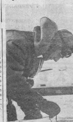
Eh los terrenos rusos ocupados se atiende a las vías ferroviarias. Así puede observarse a este zapador alemán abriendo orificios en una traviesa sobre la que ha colocarse la vía férrea.
