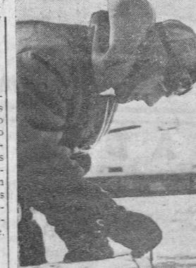
Eh los terrenos rusos ocupados se atiende a las vías ferroviarias. Así puede observarse a este zapador alemán abriendo orificios en una traviesa sobre la que ha colocarse la vía férrea.
