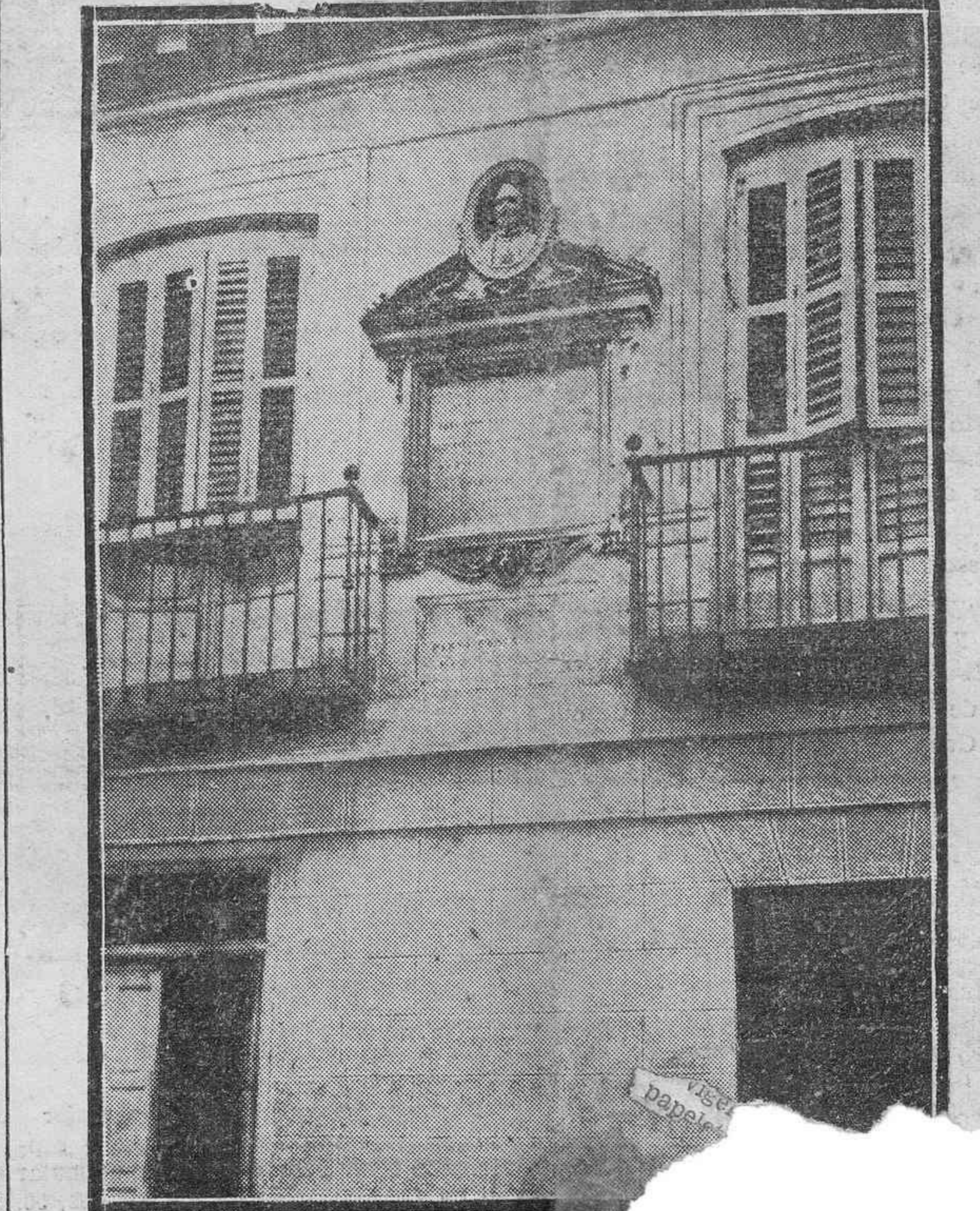
Casa de la calle de Cervantes
