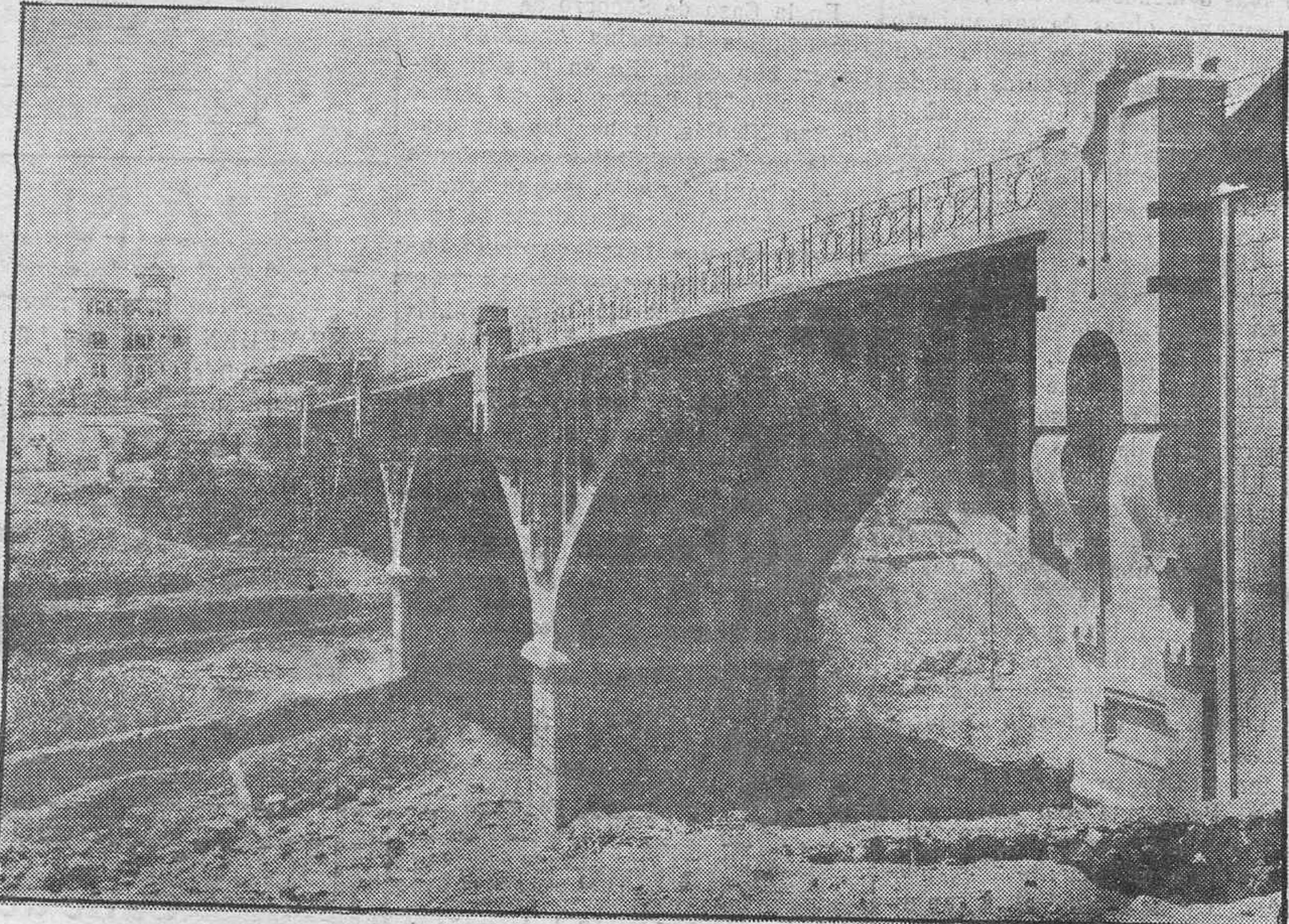
LAS OBRAS MUNICIPALES.—El nuevo puente de Galcerán, que va a ser entregado de un día a otro por la Sociedad de Construcciones Hidráulicas y Civiles, rematadora de la obra. (Foto Garriga.)
