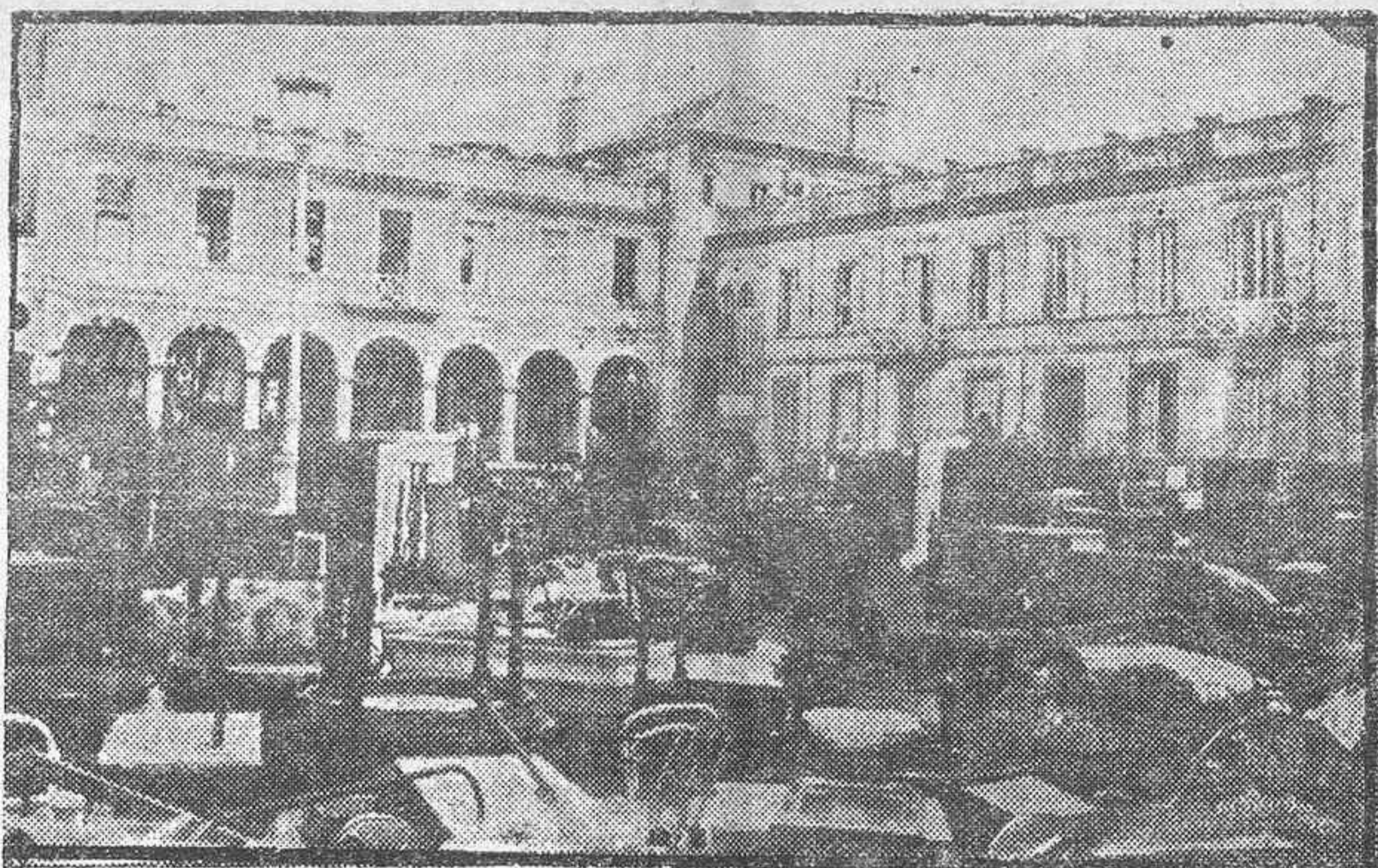
DEL INCENDIO DE AYER.—Aspecto que ofrecía el patio del Hotel al llegar nuestros repórters al lugar del siniestro.—(Foto Central.)
