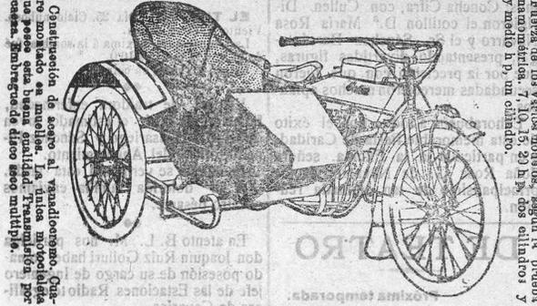
Carburador automático con chorro auxiliar. Todas con 1, 2 y 3 cambios de velocidades. La máquina más apropiada para llevar coche lateral (Side-car).
