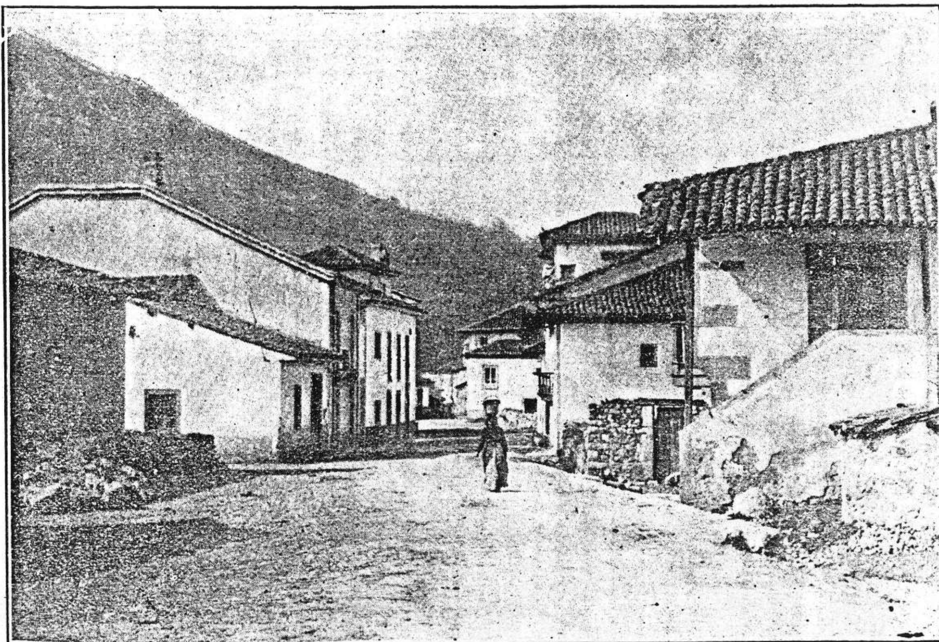
ONÍS. —La calle principal de la villa
