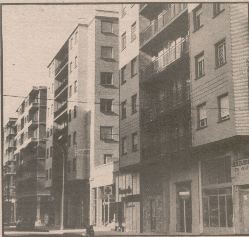
Falta suelo edificable y zona de equipamiento
