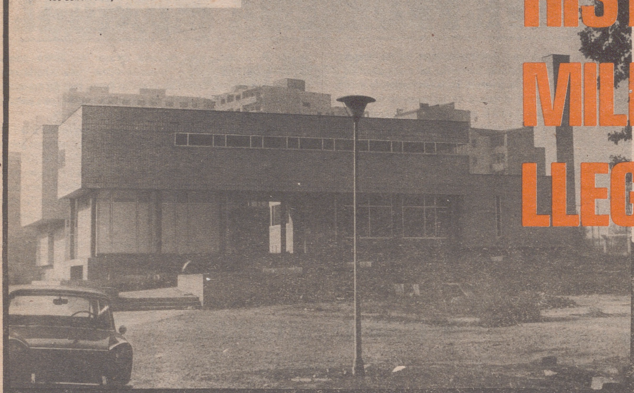
Este es el edificio del I. C. E. Cerca de él están los terrenos que se destinarán para los centros experimentales
