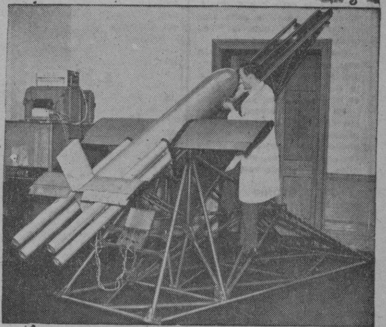
Primer proyectil británico controlado por radio. — El primer proyectil británico controlado por radio, ha realizado ya con éxito una serie completa de vuelos de prueba. El encargado ejerce un control absoluto del proyectil en pleno vuelo.
