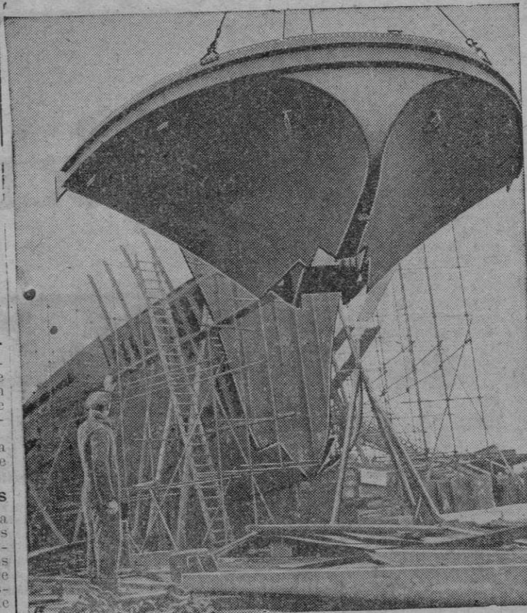
Sección prefabricada de popa de un petrolero, colocándose en posición sobre un buque en construcción en los astilleros británicos
