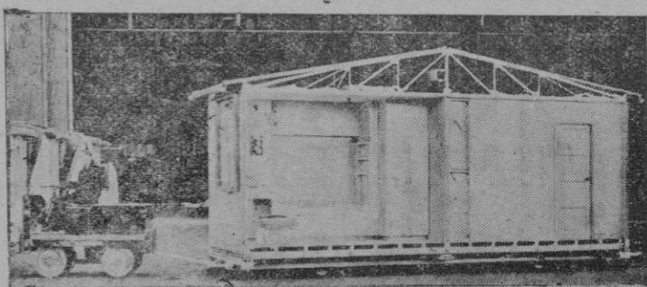
La escasez de viviendas en Inglaterra constituye uno de los principales problemas, para cuya rápida solución se ha iniciado la fabricación en gran escala de casas de madera. Una sección de una de aquellas viviendas al ser transportaba al lugar de su emplazamiento
