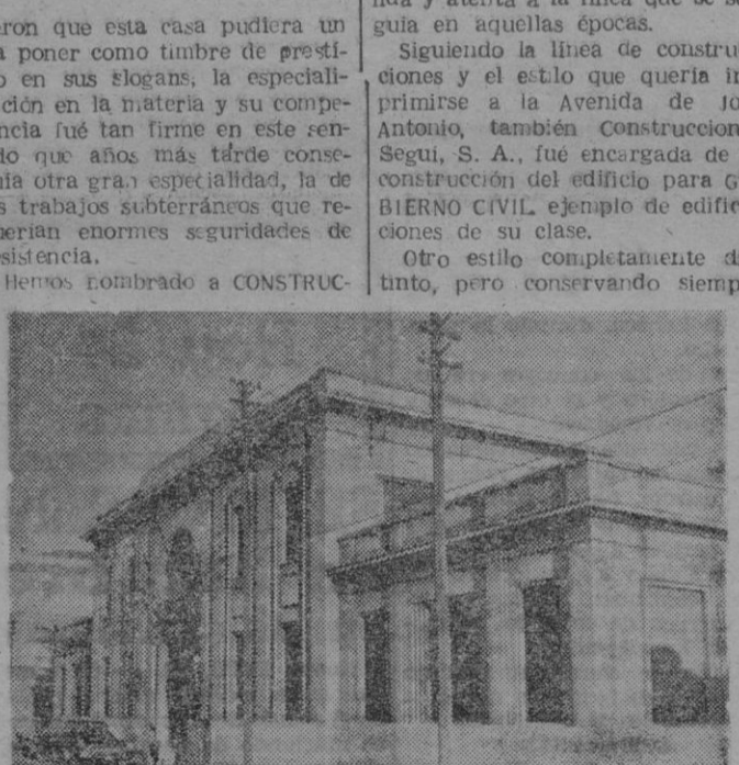
De línea sencilla, pero moderna, es el edificio que ocupa la Compañía Trasmediterránea.
