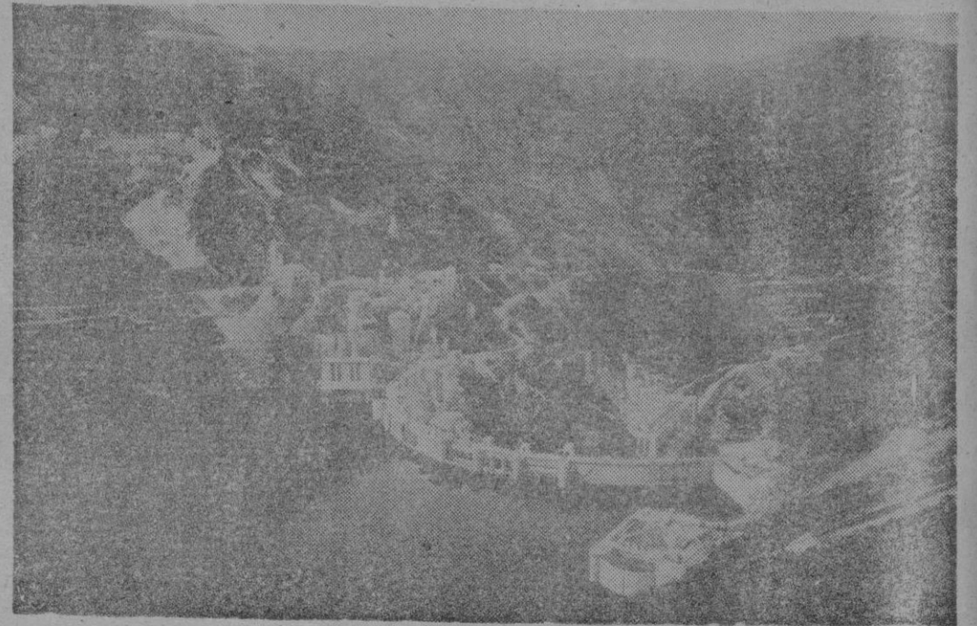
La presa y Central eléctrica en San Esteban de Sil
