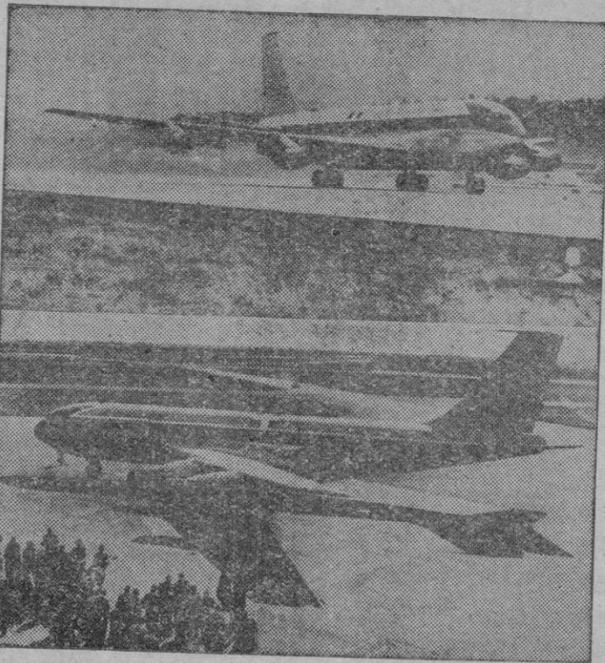
Un avión de reacción norteamericano, el Boeing-707, ha unido un extremo de Estados Unidos con el otro, cubriendo una distancia de más de 5.000 kilómetros, en tres horas y cuarenta y ocho minutos. El Boeing-707 tiene cuatro motores de turbina y capacidad para 110 pasajeros. Cuando realizó este vuelo llevaba a bordo 52 personas y mantuvo una velocidad media de 1.256 kilómetros por hora.
