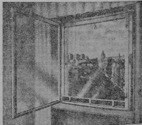
POSICION DE LIMPIEZA CON LOS CRISTALES SEPARADOS: Por estar la ventana exterior suspendida verticalmente, se pueden separar los cristales y limpiar las superficies interiores de los mismos con toda comodidad.
