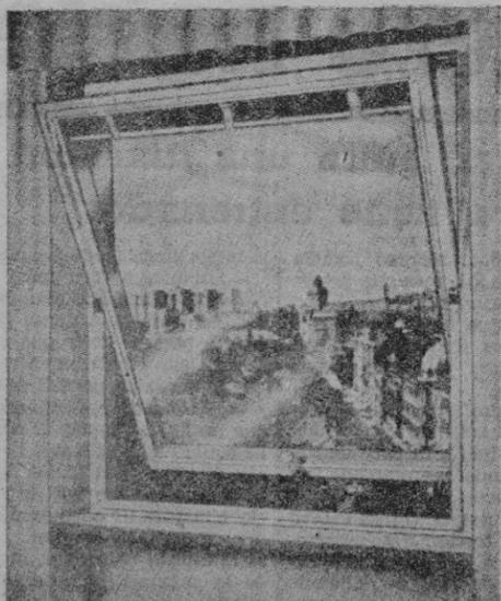
POSICION DE VENTILACION: La posición de ventilación máxima de 30º permite una ventilación rápida; se pueden obtener varias posiciones de ventilación sin que se produzcan corrientes de aire.
