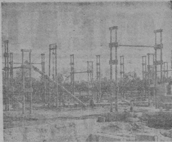
Estado actual que ofrecen las obras del parque aéreo de la subestación, en el que se aprecian las estructuras de hormigón armado. — (Foto Salas-Lluchmayor)
