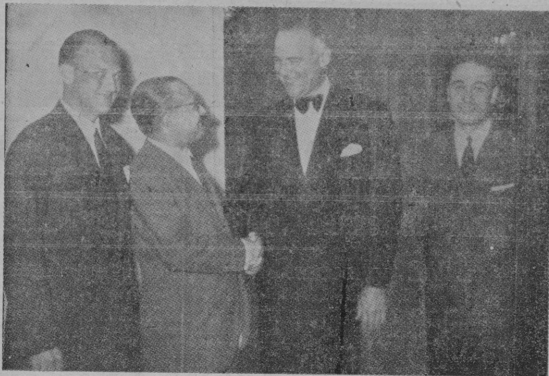
Mr. John Davis Lodge, embajador de los Estados Unidos en España durante la fiesta ofrecida en su honor en el Hotel Ritz, de Barcelona, conversa con los consejeros de la empresa Auto-Electricidad, S. A., sobre la magnífica instalación de acondicionamiento de aire efectuada por aquella firma con material "Carrier" en el nuevo edificio de la Embajada norteamericana en Madrid, que dispone así de la más importante y moderna realización de este género en España
