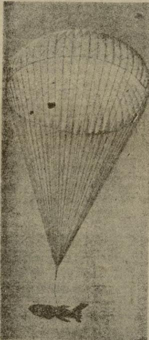
Unidos se ha efectuado recientemente las pruebas del paracaídas conducido por radio. Emplazado en el fuselaje de un pequeño avión sin piloto volando a gran velocidad el paracaídas se abre al solo deseo del piloto. El avión aterriza dulcemente. He aquí la fase final de la experiencia.
