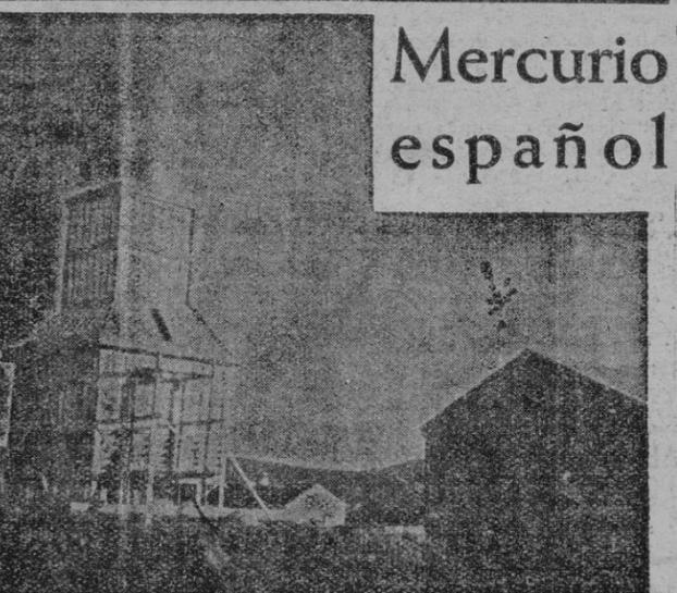
ALMADEN.—Vista del refrigerador y central eléctrica que se instalan junto a la nueva barriada. Con estas instalaciones y la de los nuevos hornos de fundición de azogue, que fundirán 50 toneladas diarias de mineral, cada uno, se conseguirá un rendimiento mucho mayor en el porcentaje a fundir de este mineral, cuya producción en 1952 llegó a los 37.000 frascos con una capacidad cada uno de 34'5 kilos (Foto "Cifra Gráfica")
