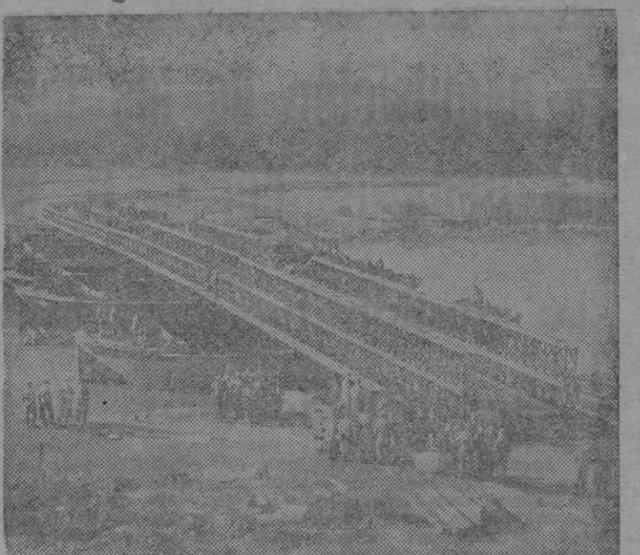
El puente «Brailey» es la respuesta de los ingenieros británicos a las demoliciones alemanas. Vemos aquí a uno de ellos construído en el frente de Italia
