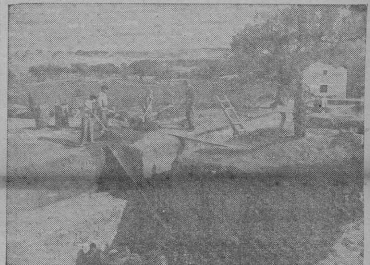
Se construyen toda clase de fortines y defensas en las costas atlánticas y mediterránea de Francia bajo la dirección de zapadores alemanes.
