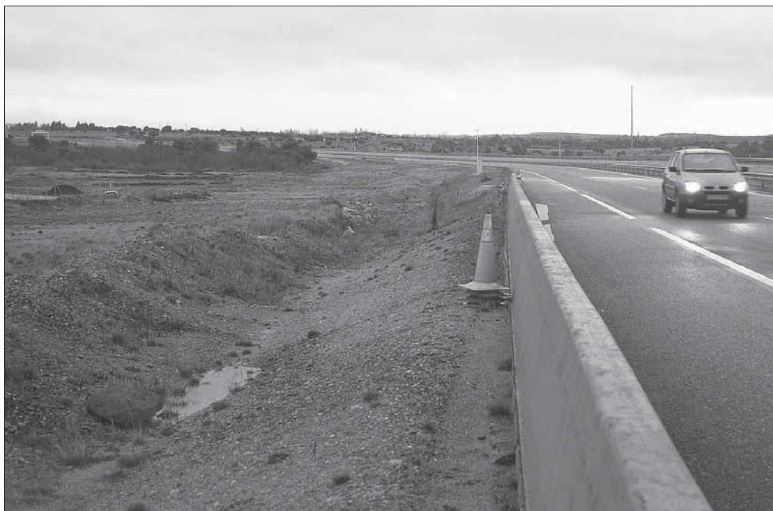
Los trabajos para explanar la zona se han realizado ya y en los próximos días se adjudicarán los de construcción del área de servicio a ambos lados de la autopista. J.M.
