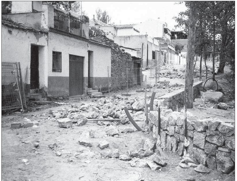
Actuación que se está ejecutando en el río Cigüñuela, junto a la calle Rosario
