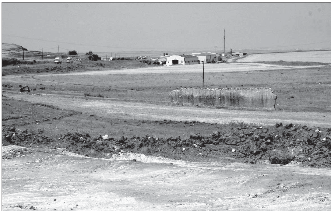
Los trabajos de desdoblamiento de la carretera CL-601 en la zona prosiguen a la vez que se analiza arqueológicamente el hallazgo PENALOSA
