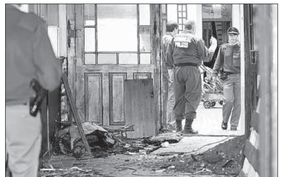
La Policía alemana inspecciona el edificio que se quemó. /EFE
