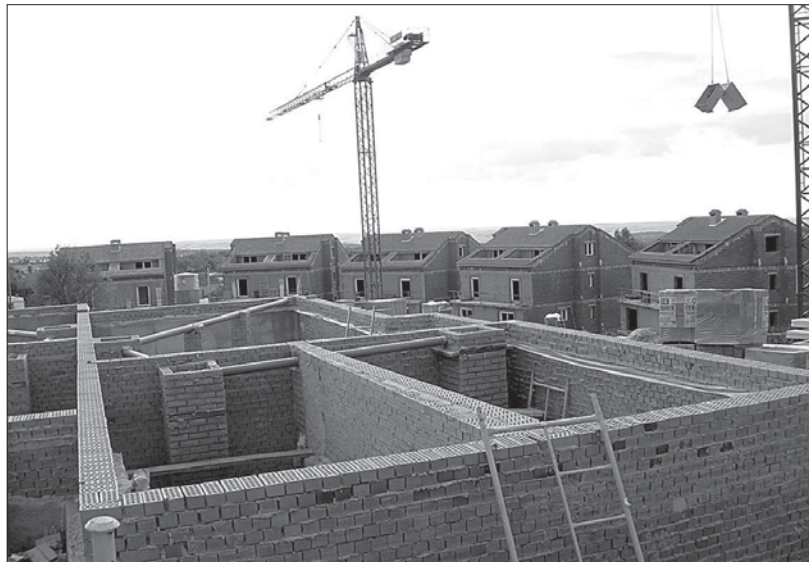
Construcción de viviendas en una zona próxima a la iglesia parroquial de Revenga / EL ADELANTADO
