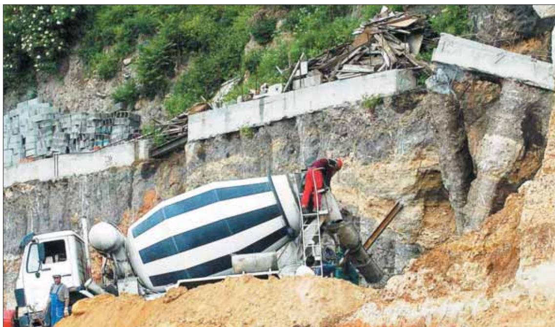
La empresa rellena con hormigón la zona en la que cedieron los pilotes que sujetaban el talud en ese punto
