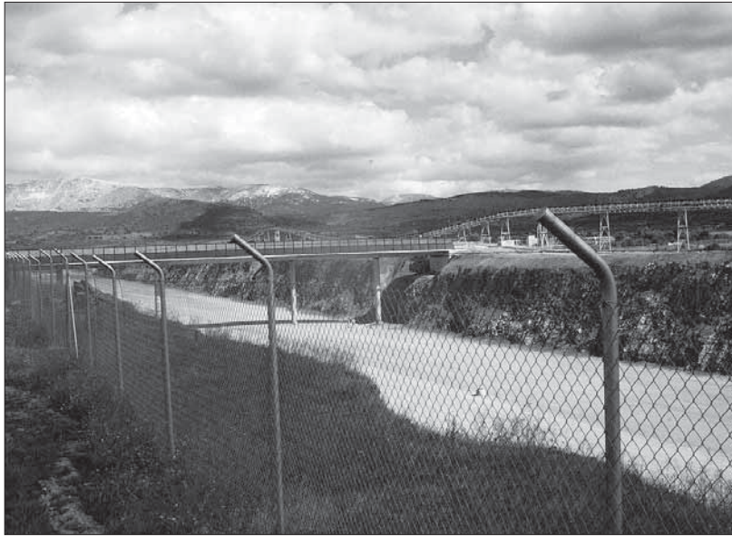
Zona en la que se ubicará la estación, con la plataforma de las vías en primer término
