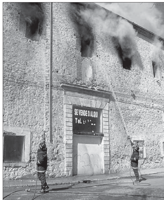
Incendio que afectó al Convento de Santa Ana
