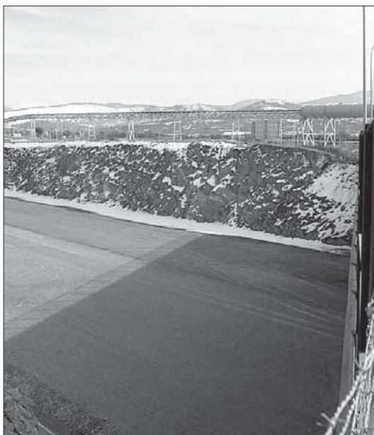
Trinchera próxima al lugar donde se ubicará la estación JUAN MARTÍN
