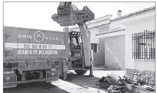
Las obras de ampliación comenzaron ayer
