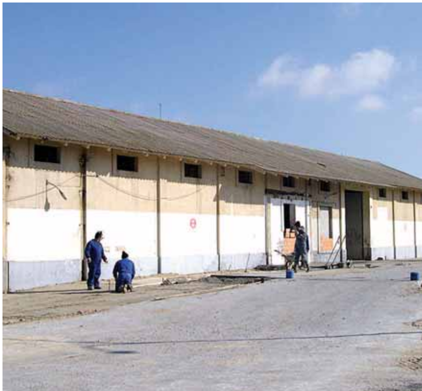
Operarios han acondicionado la antigua nave del Sempa para ampliar la superficie de expositores / C. JORGE
