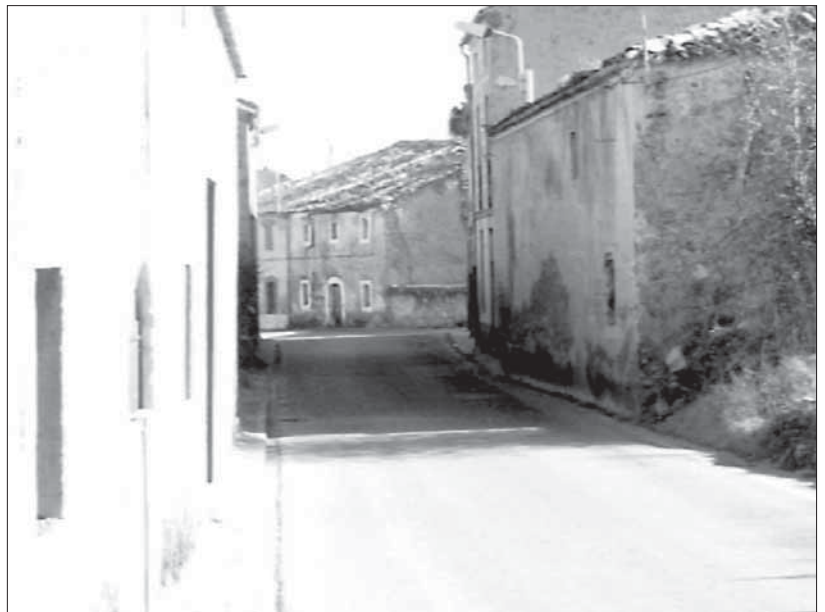
El estrechamiento, en alguno de los tramos de la travesía, es evidente
