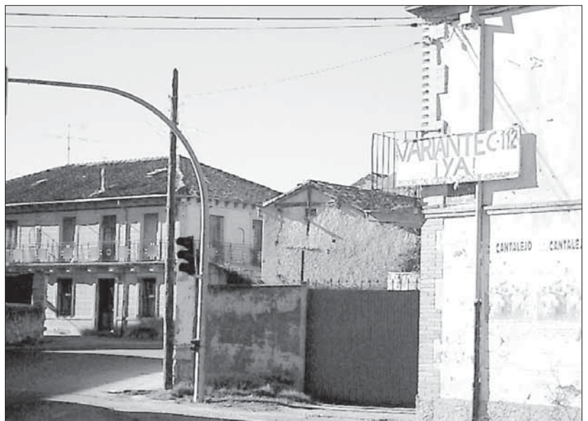
La construcción de la variante es una vieja reivindicación de la localidad
