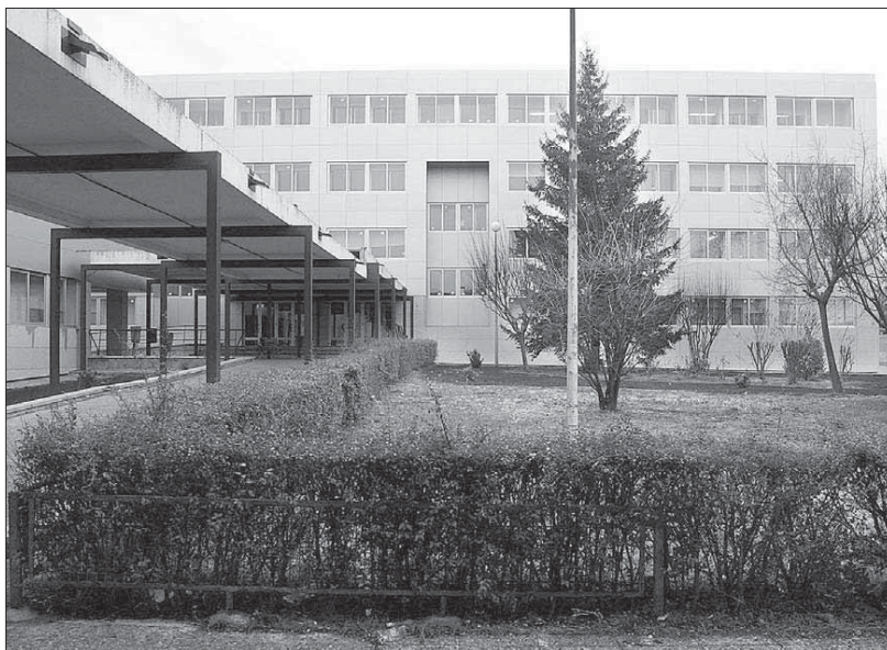
Las obras en el 'María Moliner' han consistido en la reparación del cerramiento de las fachadas J.MARTÍN
