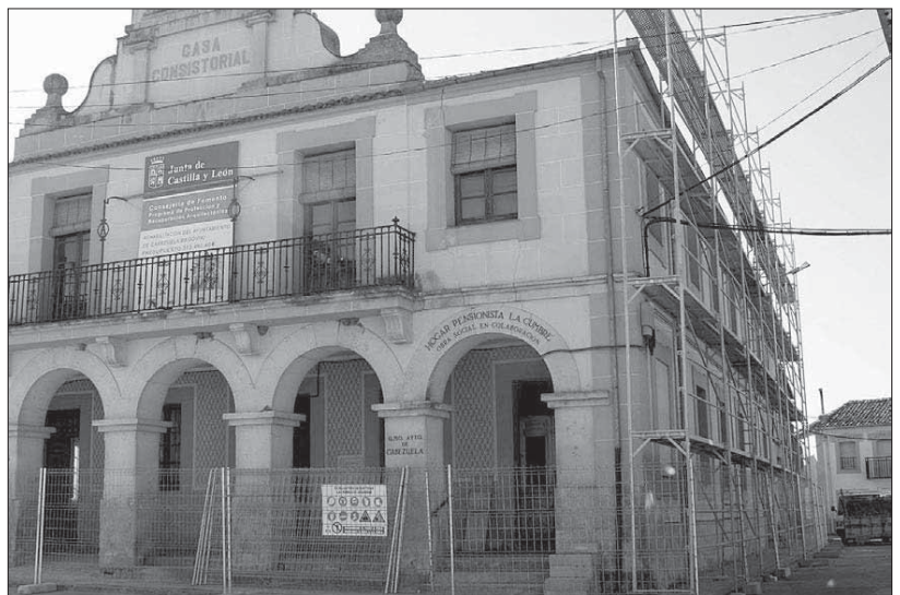
Las primeras obras se han centrado en el desmontaje de la parte interior del edificio
