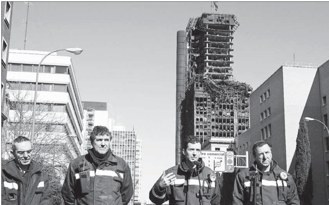
Medardo Tudela (2d), ejerció de portavoz de los cuatro bomberos de Madrid que inspeccionaron ayer por primera vez el interior del destruido Edificio Windsor. / EFE
