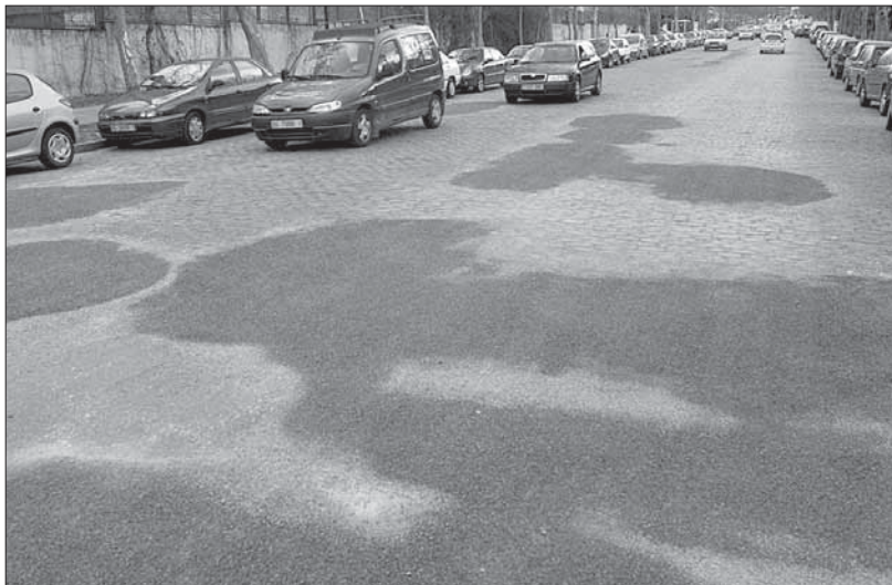
Las manchas indican los puntos reparados con aglomerado en la avenida de la Constitución JUAN MARTÍN
