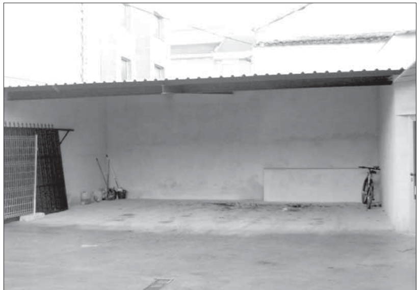
Las cocheras, en la zona exterior del centro parroquial
