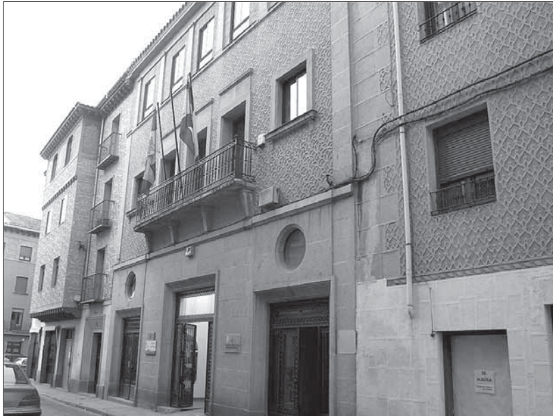
El edificio judicial alberga las sedes de ambos juzgados y del Decanato
