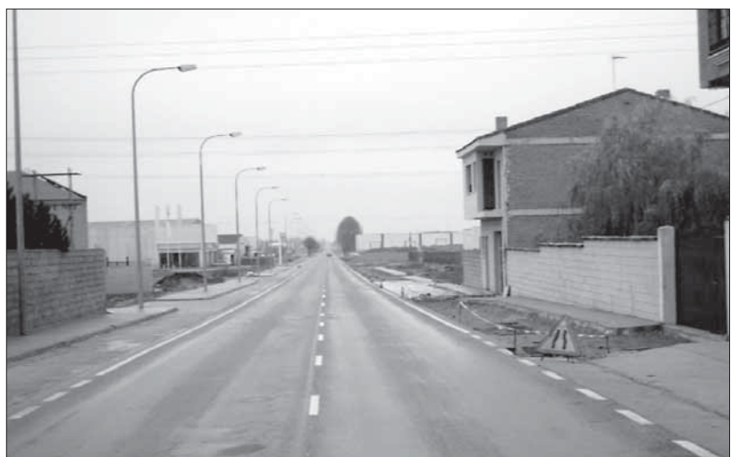
Aspecto de las obras de acondicionamiento en la carretera de Aranda
