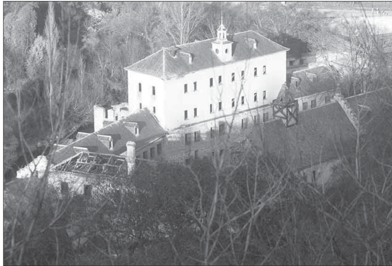
Las obras de rehabilitación de la Ceca están presupuestadas en 7,2 millones de euros
