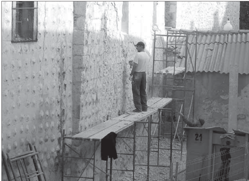
Trabajadores municipales iniciaron ayer la restauración de la fachada sur de esta capilla GABRIEL GÓMEZ
