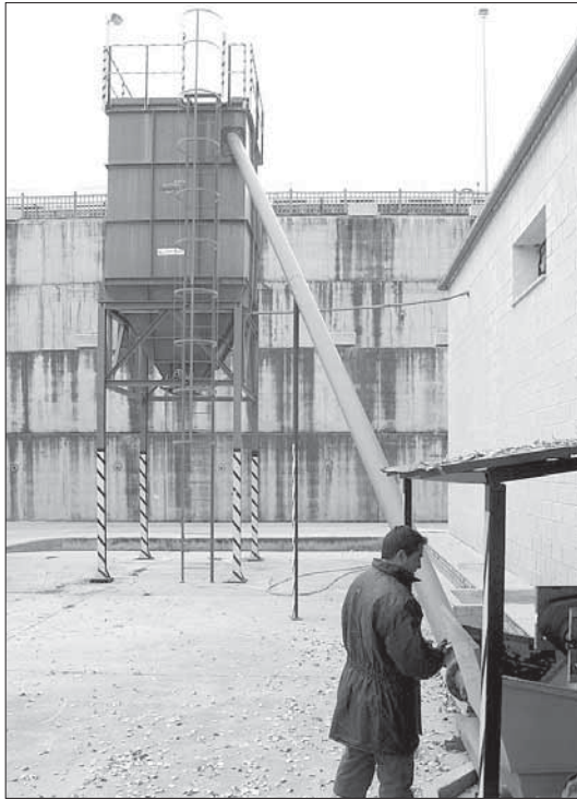
Parte de los lodos están en un silo a la espera de ser trasladados J.M.
