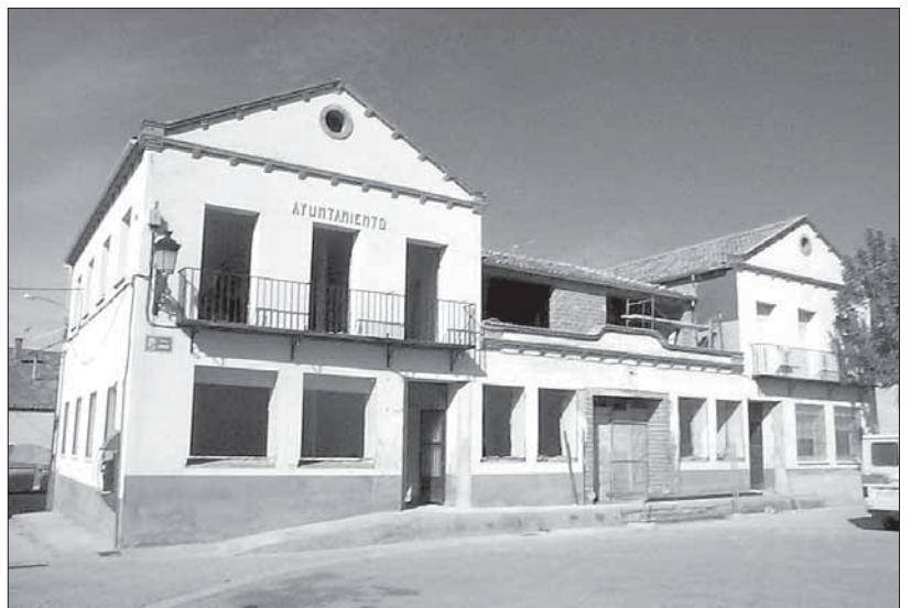
Este es el actual aspecto que presenta el edificio construido en los años 40
